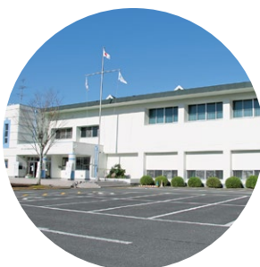
海洋センター修繕助成
