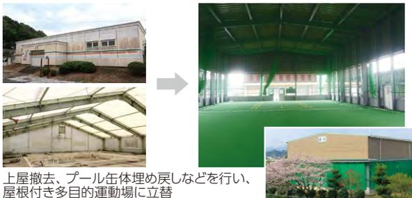
上屋撤去、プール缶体埋め戻しなどを行い、屋根付き多目的運動場に立替
