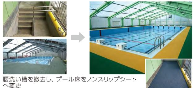
腰洗い槽を撤去し、プール床をノンスリップシートへ変更
