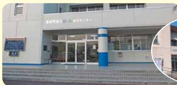
外壁全面塗装、照明自動昇降装置など、新しく生まれ変わった愛媛県愛南町御荘B&G海洋センター（左）と工事前の写真（右）
