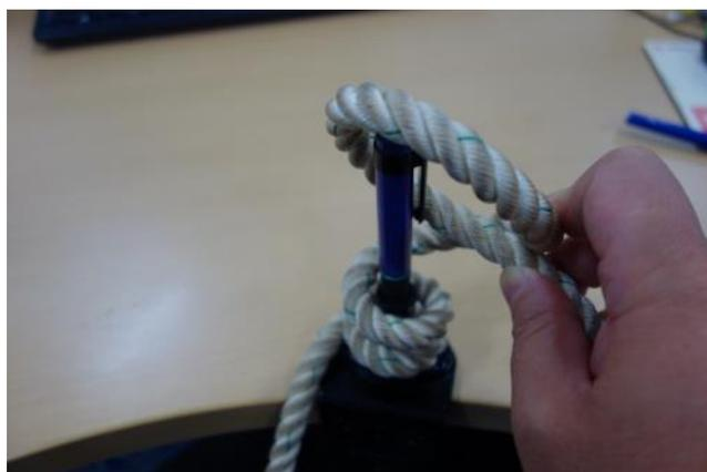
②ワラ縄の結び方。竹杭に 2 回巻き付けた後、「端」を内転して「輪」を作り、竹杭に被せる。ワラ縄は摩擦力が大きいので「巻き結び」より簡単な結び方になっています。
