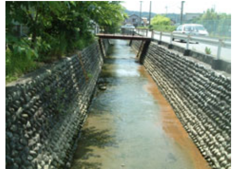
住宅街から萩間川に流れ込む排水路
